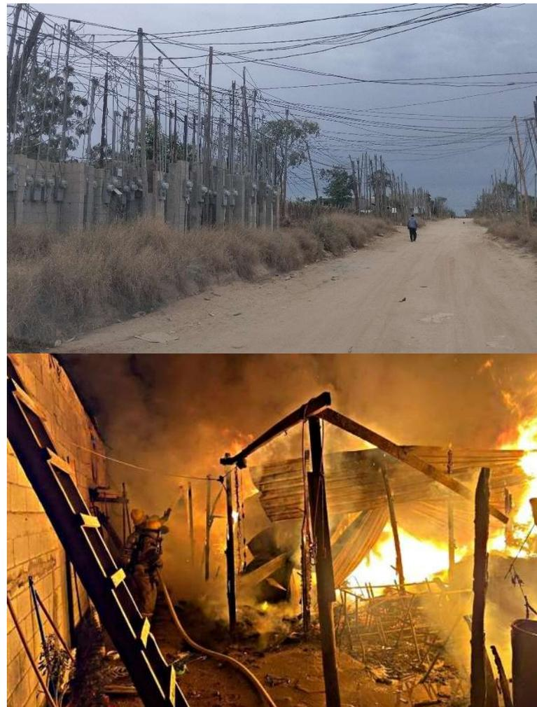
Figura 39. Instalaciones eléctricas artesanales en asentamientos irregulares en Baja California Sur (arriba), incendio en un asentamiento irregular en San José del Cabo (abajo).
